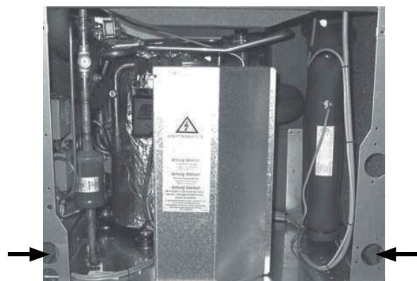
Nepoškoďte trubkami kabelové svazky a součásti v přístroji.
